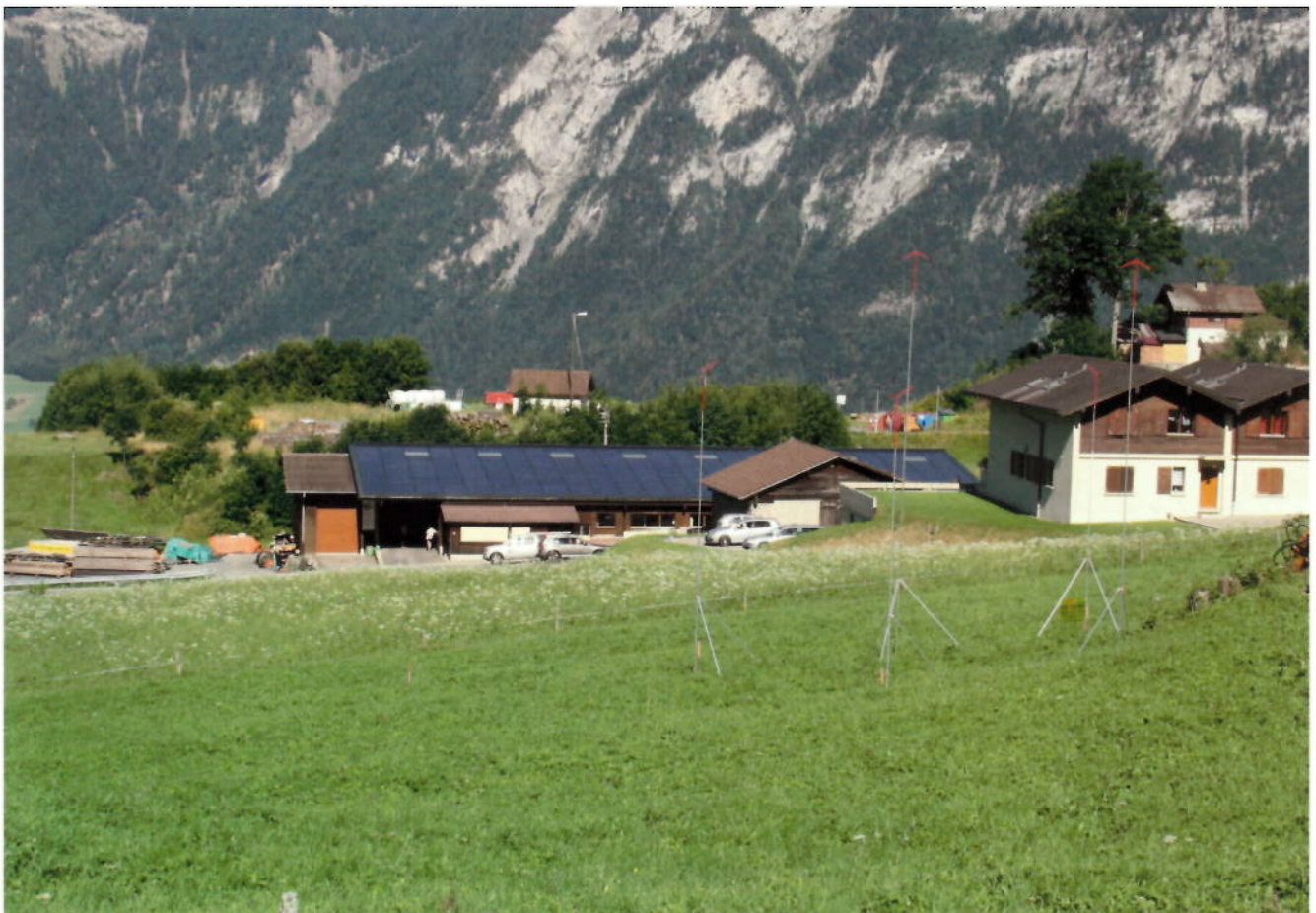
Intégration parfaite des 525 panneaux dans le paysage
