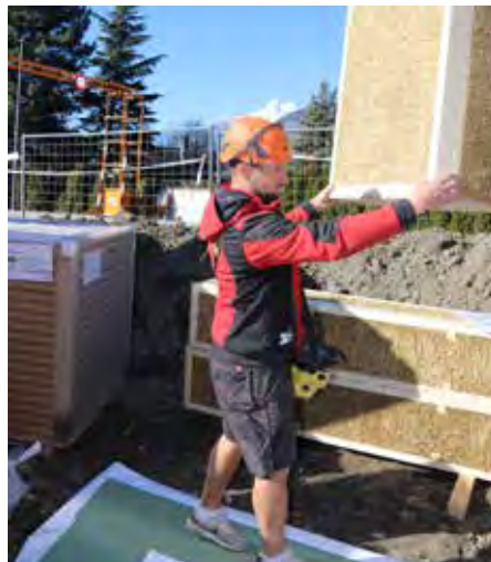
↓ Le radier est particulièrement bien protégé pour accueillir les éléments
