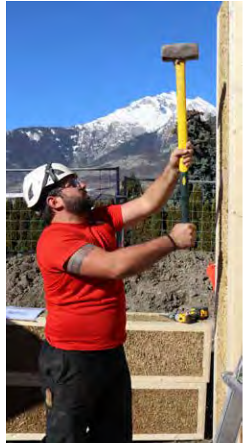
↑ Les éléments sont assemblés à l'aide de chevilles...
