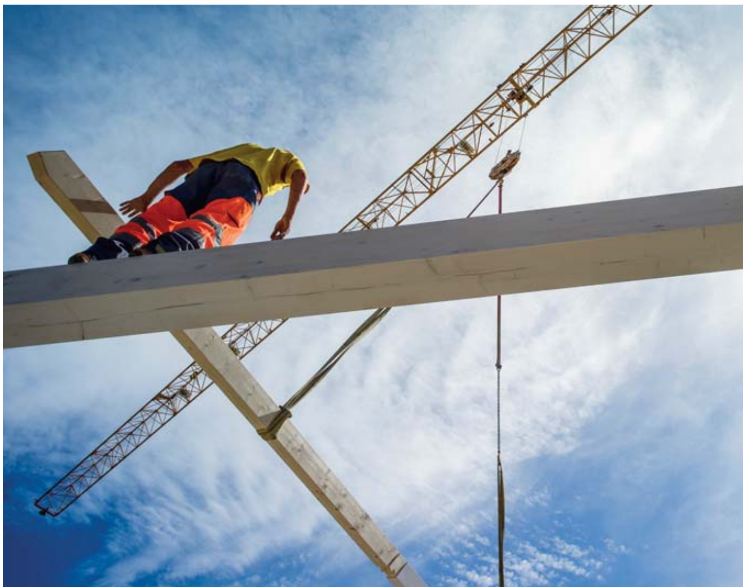
60 à 70% du bois utilisé sur les chantiers provient de l'étranger. OLIVIER MAIRE
